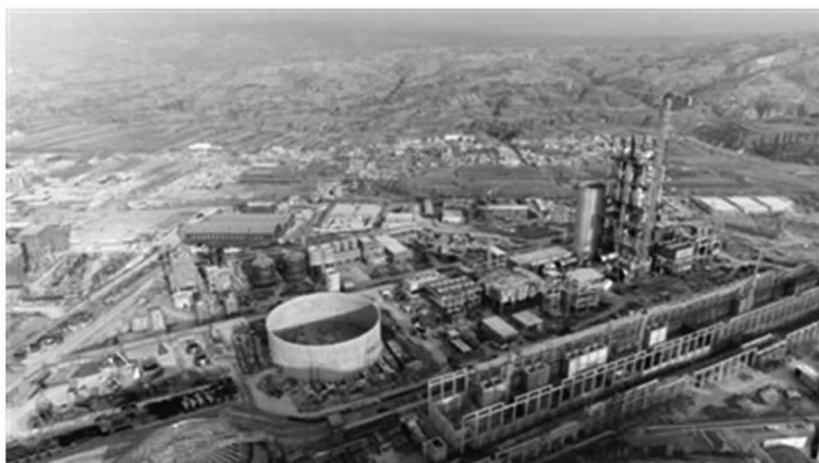
图为尧柏集团日产万吨水泥熟料生产线项目
